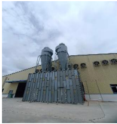
Cụm 12 xường 3 – 2 hệ thống Cyclone Công suất: 56.817 m 3 /giờ/hệ thống
